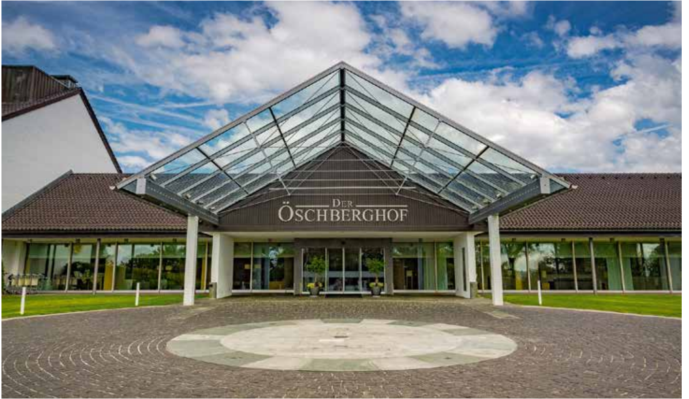
EINGANGSBEREICH BIS JUNI 2017
